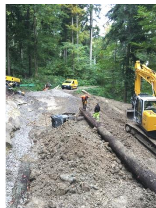
Arbeiten am „Kasten“ Es wurden Stämme übers Kreuz verlegt
