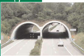
Wildbrücke über die A7
