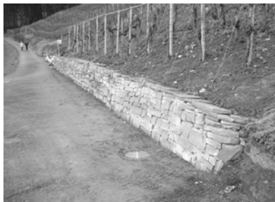
Als Beispiel zwei Massnahmen: neuer Weiher und neue Feuchtwiese, Sanierung und Erweiterung einer Trockenmauer. (Fotos: J. Barandun)
