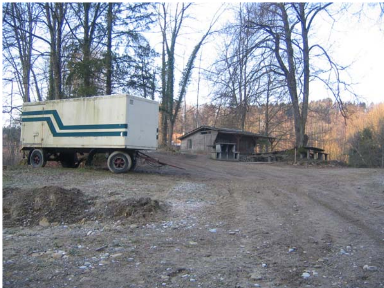
Foto Nr. 9: Wochenendhäuschen abbrechen, Abstellplatz räumen
