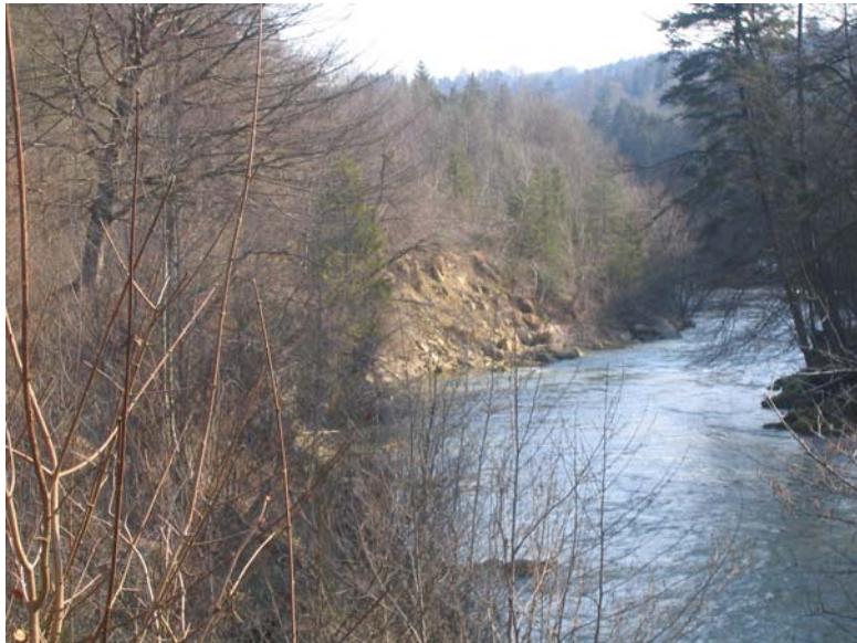
Foto Nr. 26: Schöne Erosionsböschung im Blockschuttmaterial (unterhalb Mündung HWE), km 24.8, Blick flussabwärts
