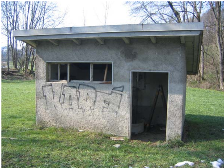
Foto Nr. 45: Abzubrechendes, Stillgelegtes Grundwasserpumpwerk; Konzessionsablauf Ende 2009 (Sitterthal AG)
