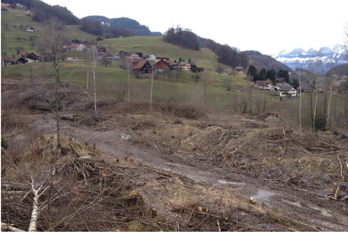
Während den Fällarbeiten (Januar 2012)
