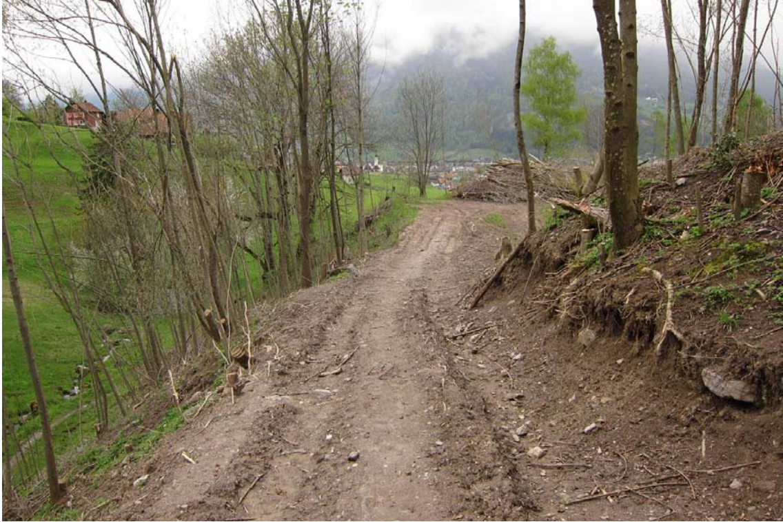
Notwendiger Rückeweg für die Gehölzarbeiten im oberen Teil der Grube
