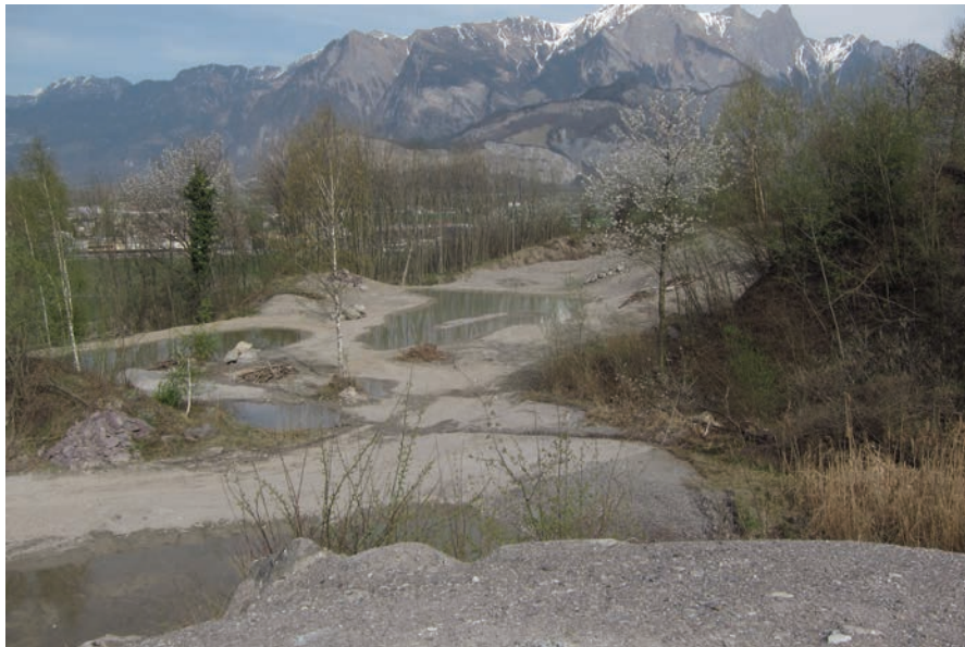
Etappe 3: Blick auf die Gewässer 4-7 kurz nach der Fertigstellung
