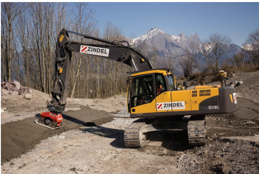
Etappe 3: Einbau der Abdichtungsschicht aus kalkstabilisiertem Kieswaschschlamm. Verdichtung mit einer Vibrationsplatte am Greifarm des Baggers
