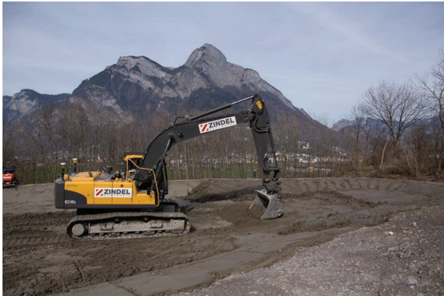
Etappe 3: Einbau der Deckschicht aus nicht stabilisiertem Kieswaschschlamm
