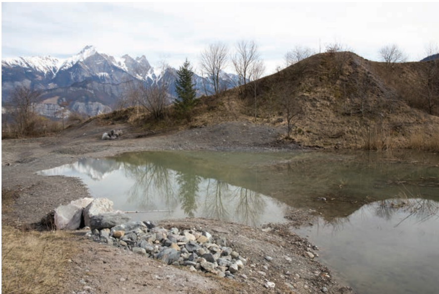
Etappe 2: Erweiterung der Flachwasserzone beim Baggersee (Gewässer 2)
