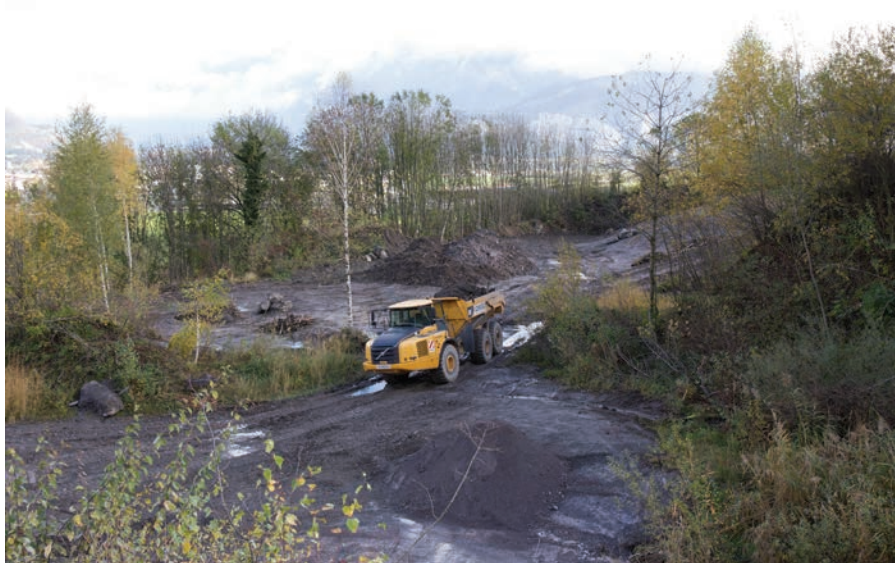
Etappe 2: Bei der Geländegestaltung wurden Transportpisten vorgegeben
