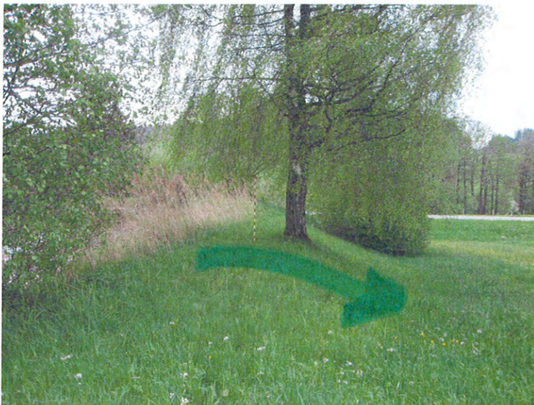
Foto Nr. 2: Damm im Bereich der vorgesehenen Hochwasserentlastung (Dammbresche)
