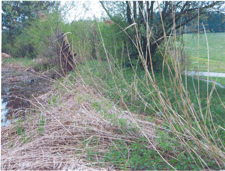
Foto Nr. 1: Bestehende Dammkrone gegen Südwesten
