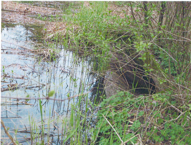
Foto Nr. 5: Bestehendes Auslaufbauwerk an südlicher Weiherecke
