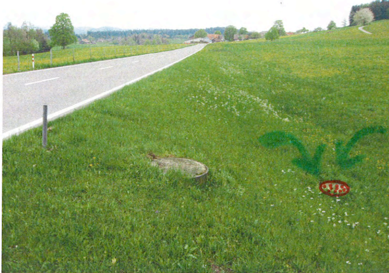
Foto Nr. 4: Rechts Kontrollschacht, der mit Einlaufdeckel versehen werden soll, um die Mulde im Entlastungsfall rascher wieder zu entleeren
