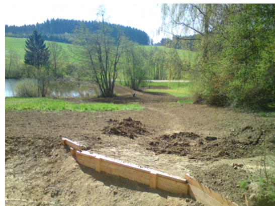
Das Bachbett während der letzten Erdarbeiten und kurz vor der Neuansaat. Im Vordergrund ist der mit Holz gesicherte Überlauf des Teiches zu erkennen.
