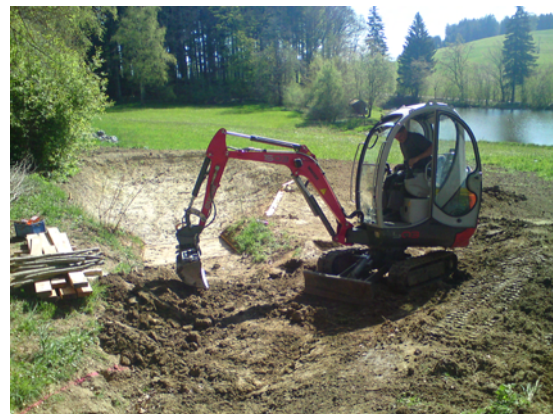
Letzte Arbeiten am Einlauf des Weihers mit dem Kleinbagger.
