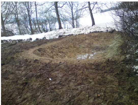
Der frisch ausgehobene Weiher während den Erdarbeiten im Winter. Gut zu erkennen ist die sehr lehmige Bodenbeschaffenheit.
