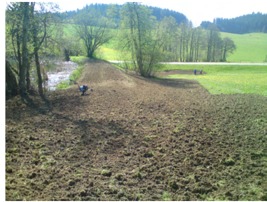
Blick aus nördlicher Richtung auf den neu erstellten Überlauf des Damms. Die Neigung wurde durch Anschütten von Aushubmaterial reduziert.
