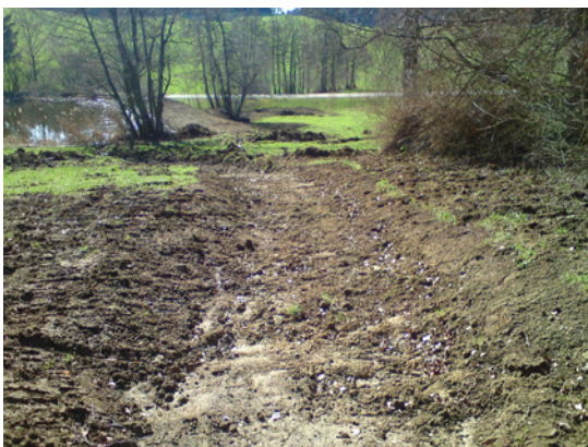
Die neu ausgehobene Rinne für den Wiesenbach nach den ersten Bauarbeiten.
