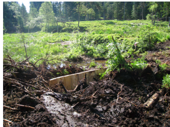
Abb. 8: Blick auf neue Spundwand im nördlichen Graben aus westlicher Richtung.
