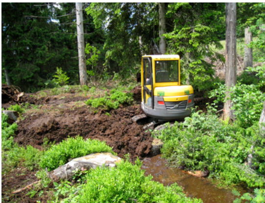
Abb. 7: Blick auf Auffüllung des nördlichen Entwässerungsgraben aus östlicher Richtung.
