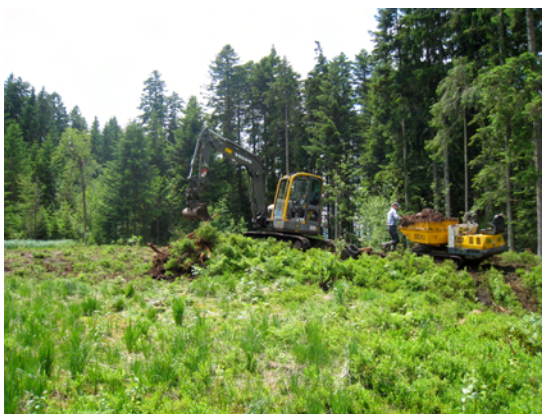
Abb. 3: Abtrag des letzten Stücks Moorrücken. Blick aus östlicher Richtung.
