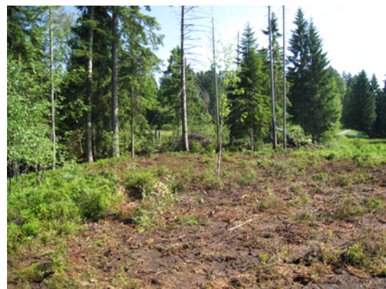
Abb. 4: Abgeschlossene Bauarbeiten. Blick auf das ausnivellierte Moor aus südlicher Richtung.
