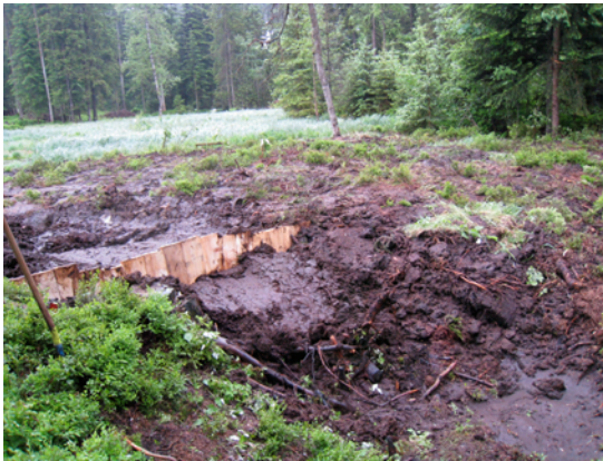
Abb.5: Blick auf bedeckte Spundwand im südwestlichen Graben aus nördlicher Richtung.
