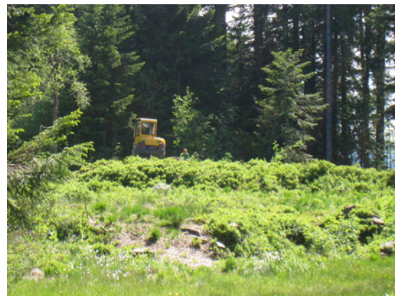
Abb. 2: Beginn der Bauarbeiten. Blick auf Moorrücken aus südwestlicher Richtung.
