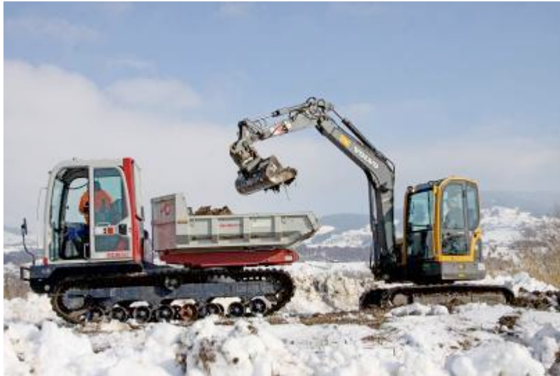
Abb. 2: Mit einem kleinen Raupenbagger wird auf 4'000 m 2 Fläche eine Schicht von 25 cm Mächtigkeit an Vegetation und Substrat abgeschält (Titelfoto und übrige Fotos © Klaus Robin)
