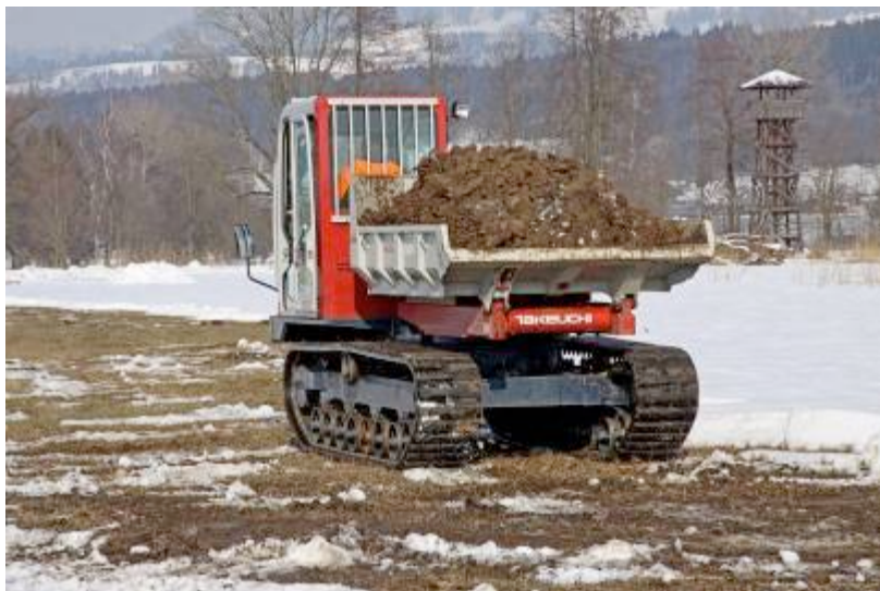
Abb. 3 und 4: Mit einem Raupendumper und einem Allradlaster für den landwirtschaftlichen Einsatz wird das Material weggeschafft.
