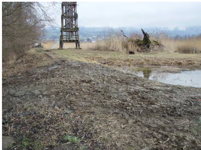
Abb. 4: Sanierte Leckstelle westlich vom grossen Turm
