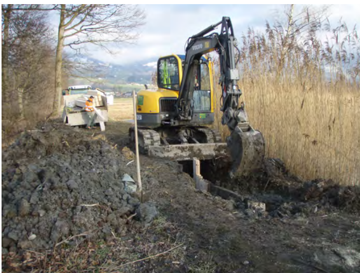
Abb. 3: Baustelle im Bereich der mittleren Leckstelle zwischen Infopavillon und grossem Turm
