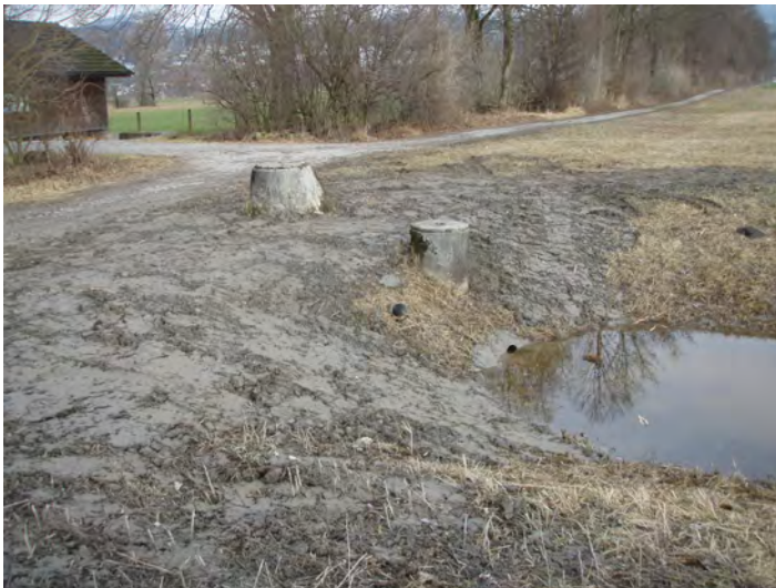
Abb. 2: Sanierte Leckstelle beim Leitungsschacht des Böschkanals
