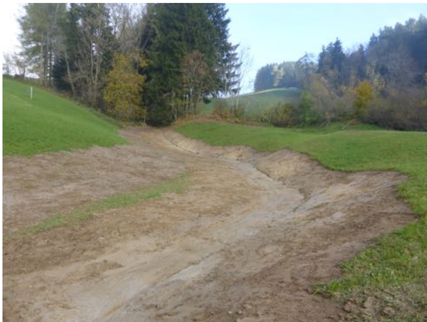
Abbildung 5: Offenlegung oberer Ettenbergbach, kurz nach dem Eingriff (Foto: Martin Brunner).
