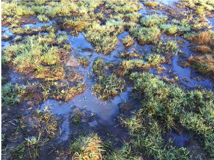
Abbildung 5: Deutlich vernässte Bodenstelle nach Einbau einer Spundwand (Foto: Ch. Meienberger)
