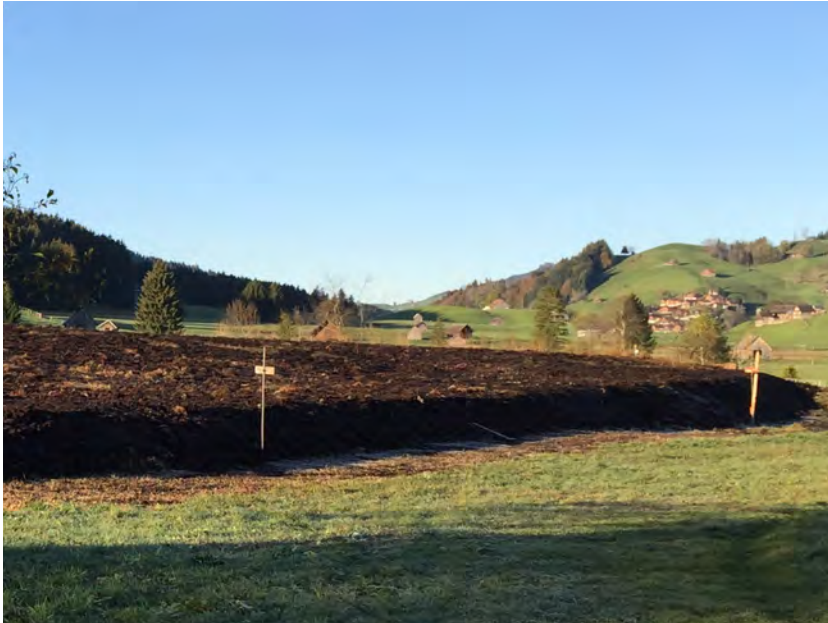
Abbildung 3: Blick auf den westlichen Teil des künstlich geschütteten Lehmdammes entlang der nördlichen Parzellengrenze (Foto: A. Zurbuchen).
