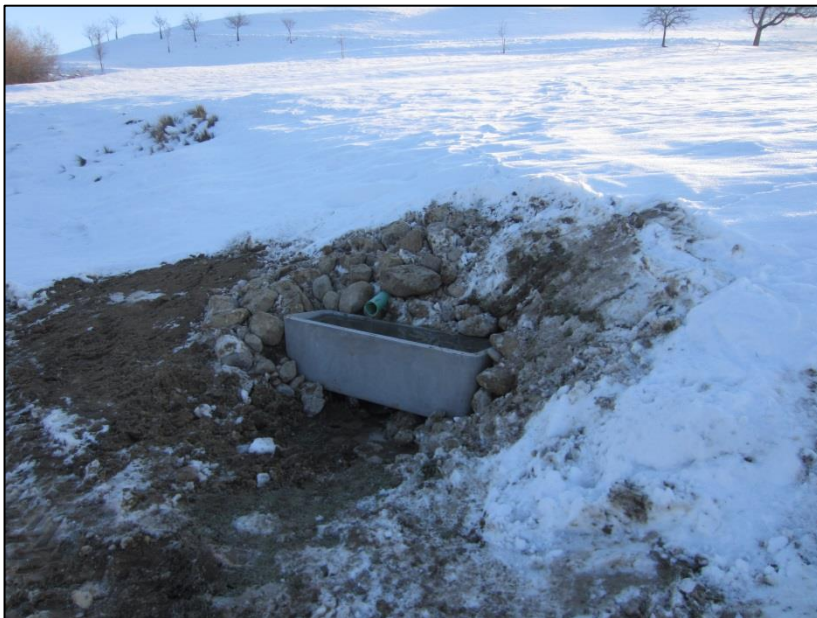
Nachher: Ein Brunnentrog mit angrenzender Unterschlupfmöglichkeit wurde installiert. (5.12.2013)
