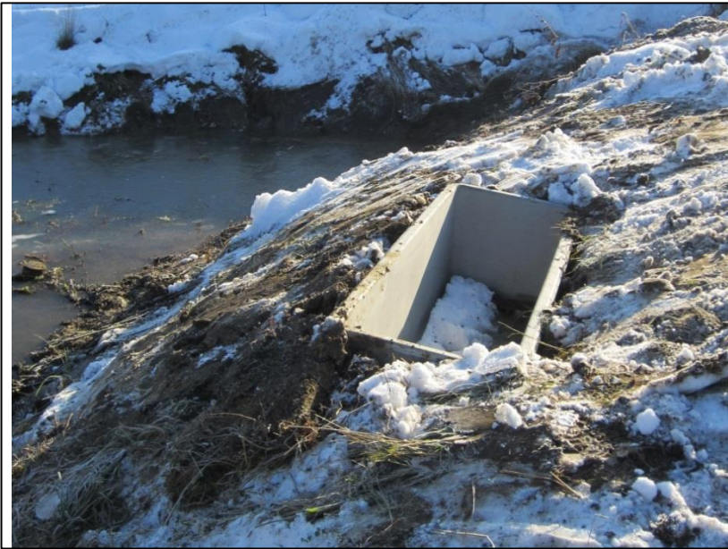
Nachher: Ein Brunnentrog wurde versenkt. Angrenzend werden noch Unterschlupfmöglichkeiten geschaffen. (5.12.2013)
