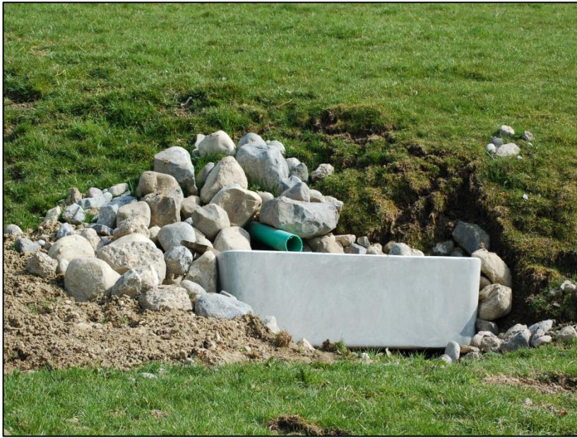
Nachher: Der Brunnentrog wurde in die bestehende Böschung integriert. (31.3.2014)
