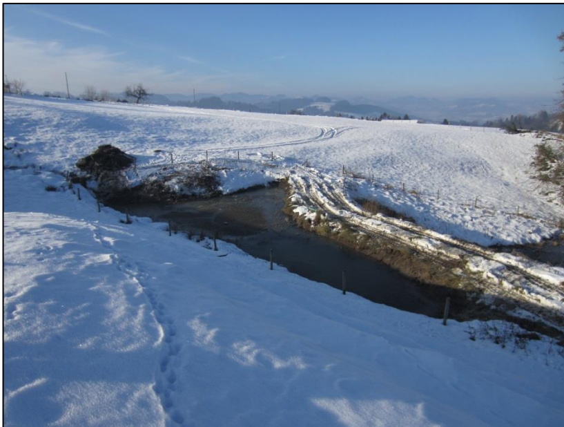
Nachher: Die verlandeten Bereiche des grossen Weihers B wurden ausgebaggert. (5.12.2013)
