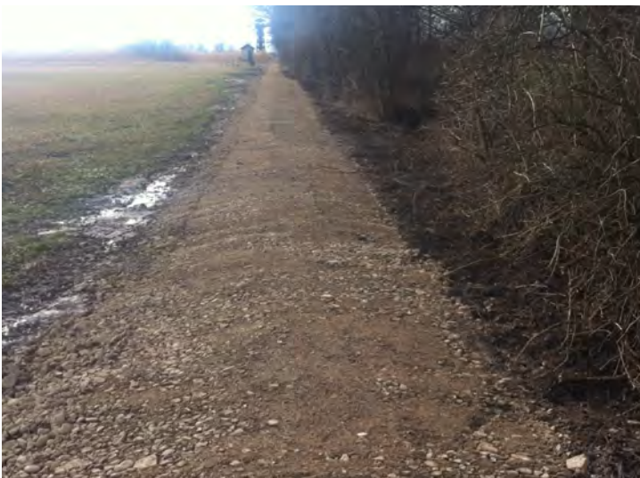
18.02.2016: Der Zufahrtsweg wurde neu eingekiest und wieder hergestellt
