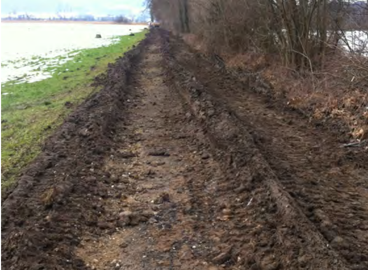
28.01.2016: Der Zufahrtsweg zum Projektperimeter wird stark beansprucht durch den Materialtransport
