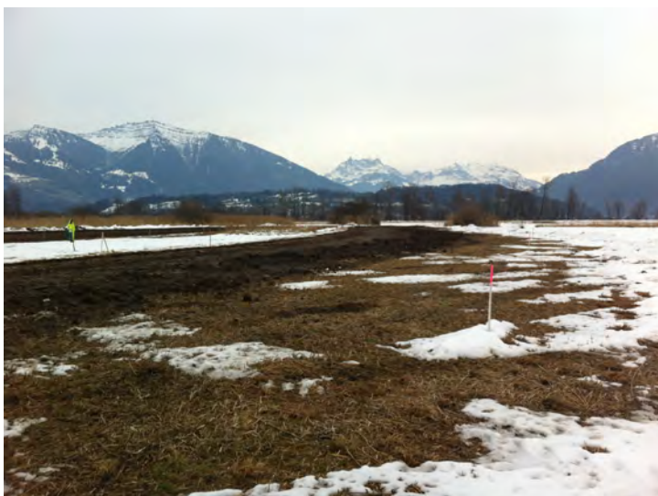
28.01.2016: Die westliche Teilfläche ist zur Hälfte abgeschürft
