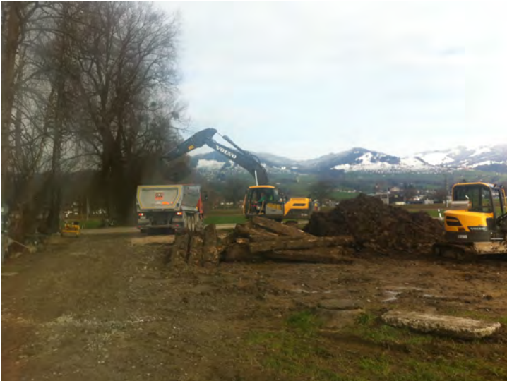
18.02.2016: An fünf Tagen wurde bei geeigneter Witterung das Aushubmaterial abtransportiert
