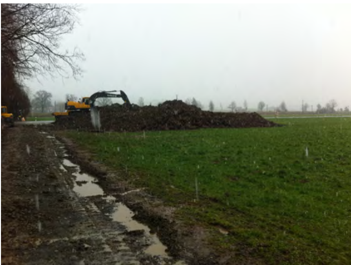
03.02.2016: Das Zwischenlager nach Abschluss der Abschürfungen
