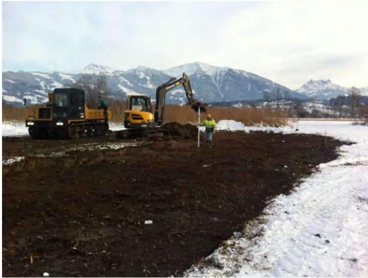
18.01.2016: Beginn Abschürfarbeiten östliche Teilfläche
