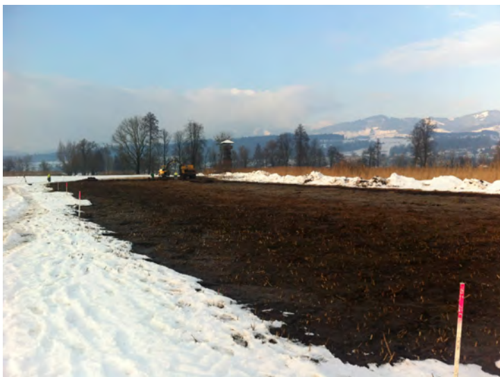
21.01.2016: Ein grosser Teil der östlichen Teilfläche ist bereits abgeschürft.
