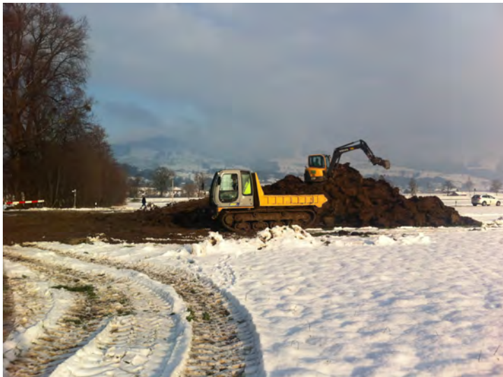
21.01.2016: Zwischenlager des Aushubs an der Benknerstrasse
