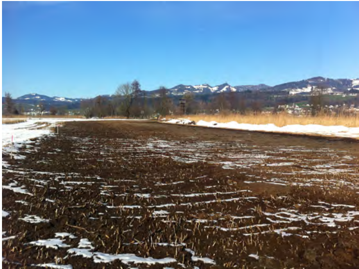
26.01.2016: Die östliche Teilfläche ist fertig abgeschürft
