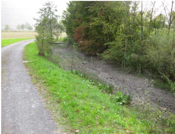
Abb. 5: Nachzubaggernder, verlandeter Bereich in Etappe IIIb (Verbindung zum Entsumpfungskanal) wird auf Deponie geführt (24.09.09)
