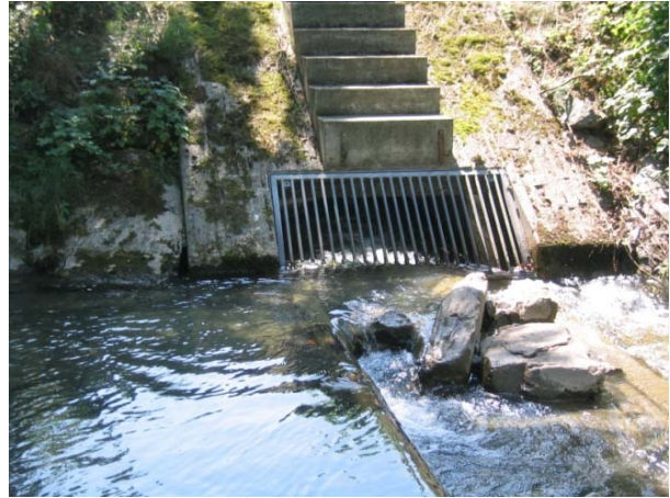
Abb. 4: Seitliche Entnahme am Neuen Berschnerbach: Testphase mit Rundholz und Bruchsteinen, welche bei Niederwasser den Stromstrich zum Dosierwerk konzentrieren (12.08.03)
