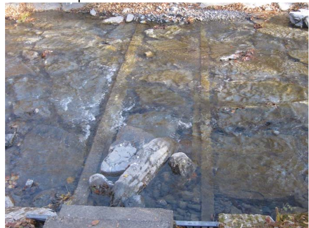
Abb. 8: Ersetzen einiger Steine in der ehemaligen Sohlnahme durch leicht höhere Steine führt zu Anstau bei Niedrigwasser und früherem Anspringen der Entnahme (11.11.11)
