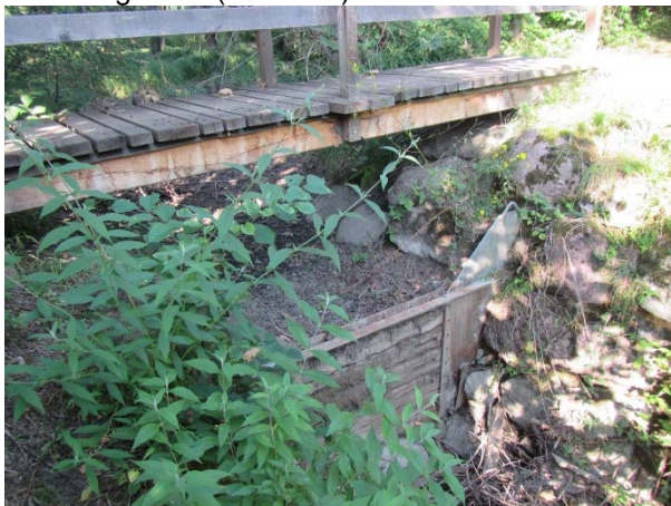
Abb. 7: Durch die Abdichtung des Wehres zum Hintergraben wird der Wasserverlust aus dem Aufstaubereich reduziert (12.09.18)
