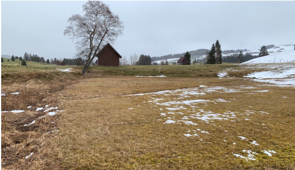
Abbildung 3 Blick auf die Entwässerungsgräben auf Parzelle 514 (Blick von West nach Ost).
