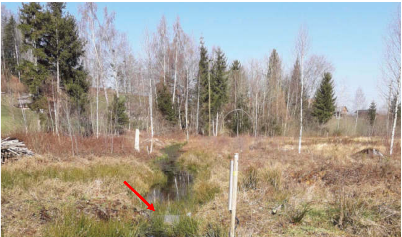
Abb. A3.4: Randrinne mit höhenregulierbarem Überlauf (roter Pfeil; Foto Naturplan AG).
