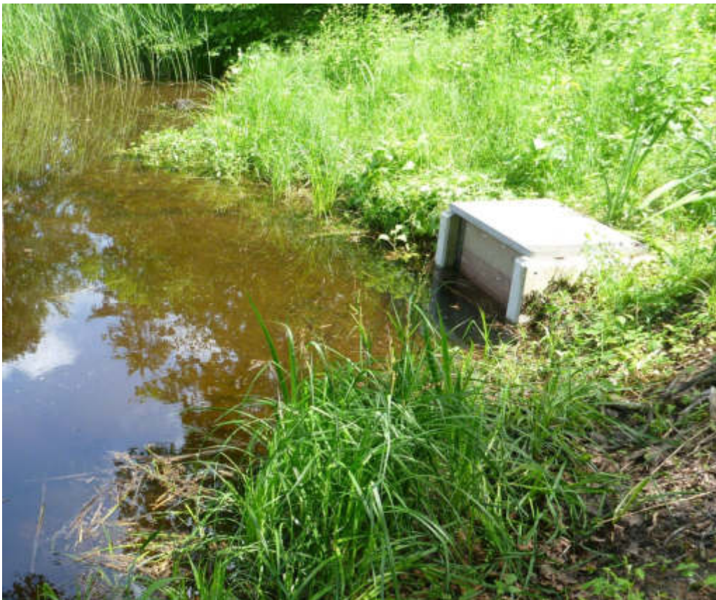
Abb. A3.6: Regulierschacht «Mönch» (Beispielbild Naturplan AG).
