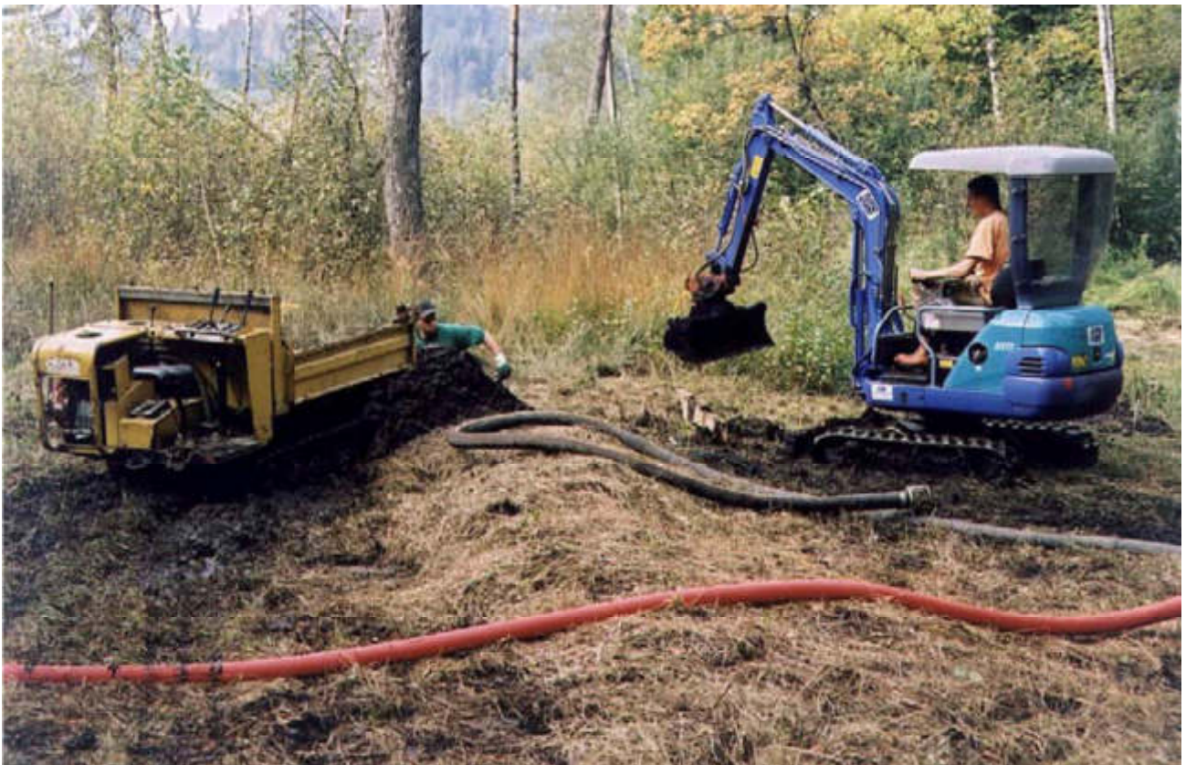
Abb. A3.2: Oberflächendamm mit Kernspundwand nach Torfeindeckung (Foto Naturplan AG).
