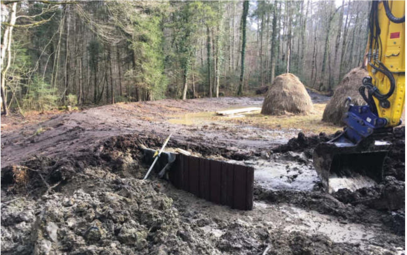
Abb. A3.3: Oberflächendamm mit Kernspundwand aus Vinyl und Lehmkern im Bauzustand (Foto Naturplan AG).
