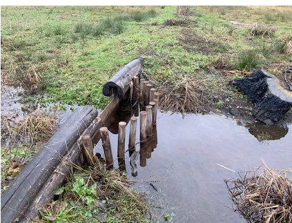
Geöffnetes Wehr zum Wasserablass für die Streuemahd.
