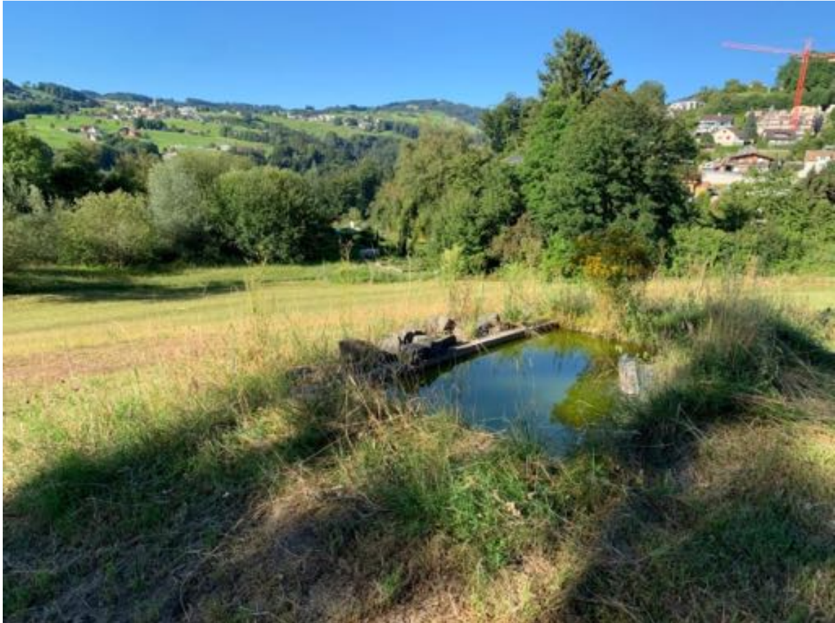
Abb. 8: Im Boden versenktes Betonbecken
